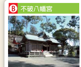
B 不破八幡宮 文明年間(1469~1487)，一條氏為了從京都的石清水八幡宮將神祇恭迎至備多、作為當地的守護神，因而興建了不破八幡宮。正殿採用三殿並列結構，屋頂則鋪設木質板材，建築樣式具有濃厚的室町時代風格。被評選為日本的國家重要文化財。
