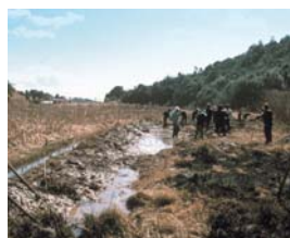
整修中的蜻蜓池
