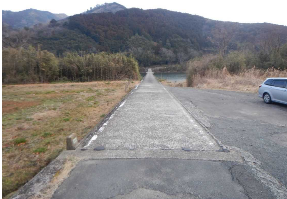
高瀬橋_現場写真①
