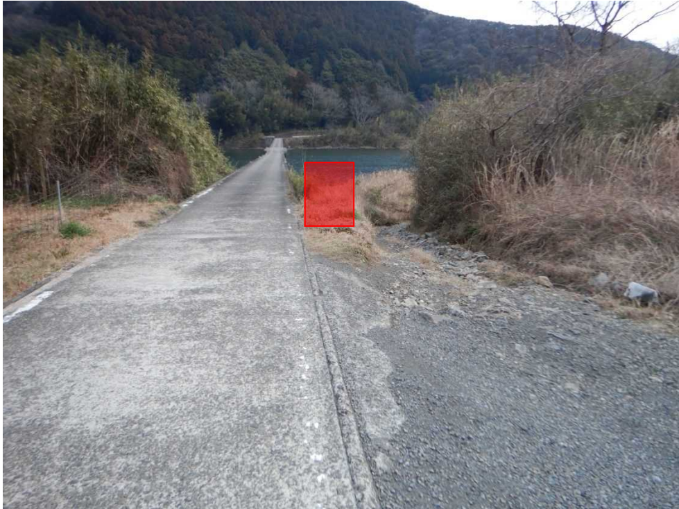
高瀬橋_事前看板設置箇所写真①
