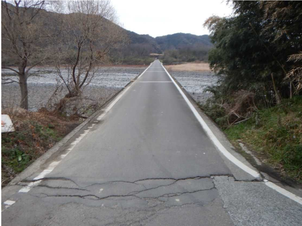
今成橋_現場写真①
