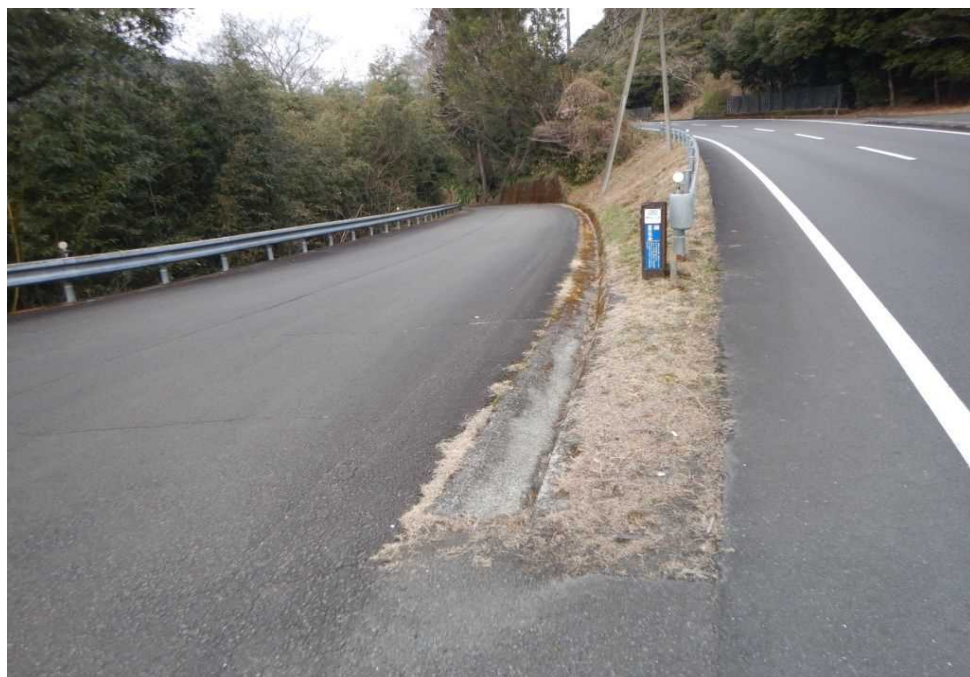
市道高瀬橋_現場写真②
