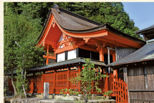
本殿は国の重要文化財
